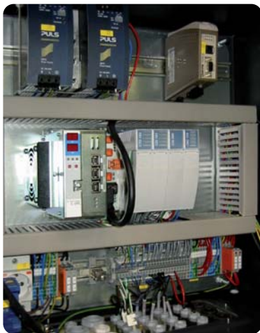
Bild 2: Das innovative Steuerungskonzept ist auf Basis der C-Dias-Technologie von Sigmatek realisiert. Durch Einsatz des hart-echtzeitfähigen Varan-Bus reicht eine einzige CPU aus, um alle Steuerungs- und Visualisierungsaufgaben zu übernehmen.
